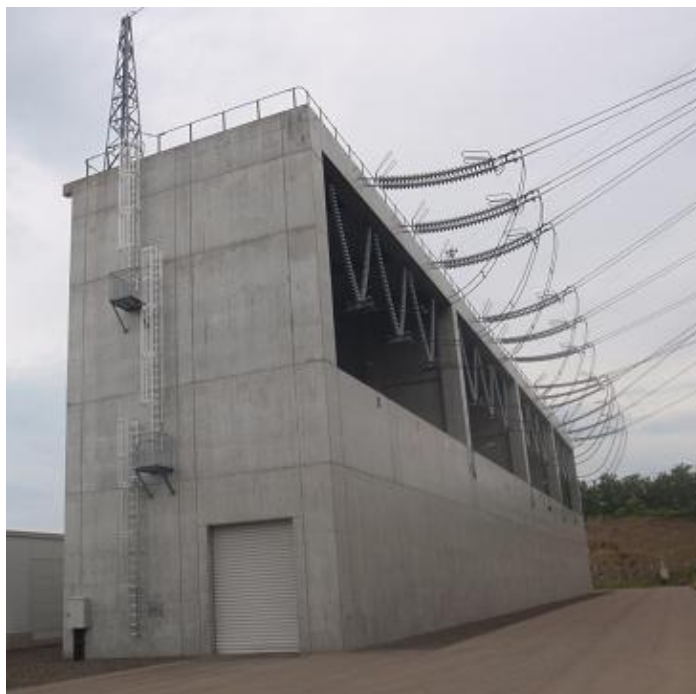
図14. 1 開閉所(遮風建屋)
