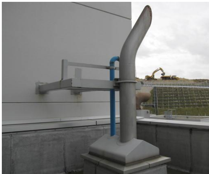
図4. 13 タービン動補助給水ポンプの蒸気大気放出管
