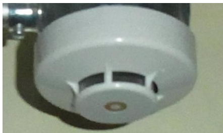
光電アナログ式スポット型煙感知器
