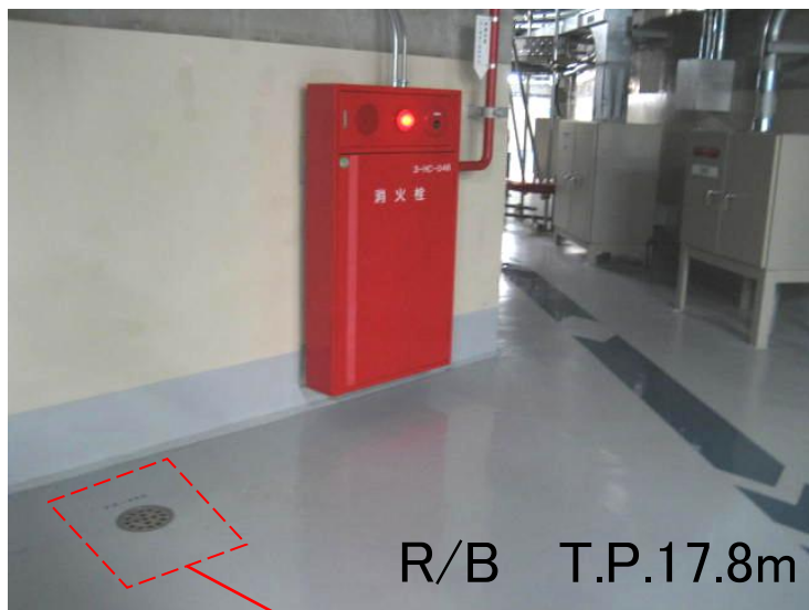
原子炉建屋、原子炉補助建屋各階の目皿
