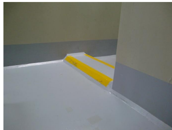
堰(ほう酸ポンプ室出入口)
