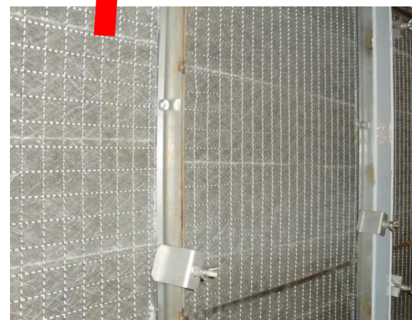
フィルタユニット内部 (フィルタ取り付けイメージ)
