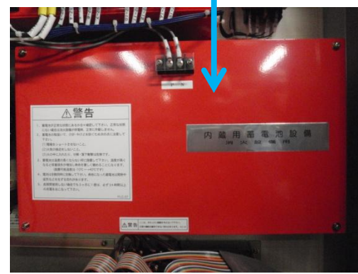
ディーゼル発電機設備 二酸化炭素消火設備
