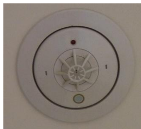
差動式スポット型熱感知器
