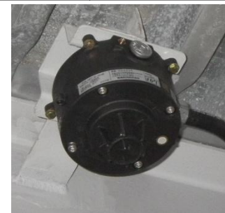
定温式スポット型熱感知器(防爆型)
