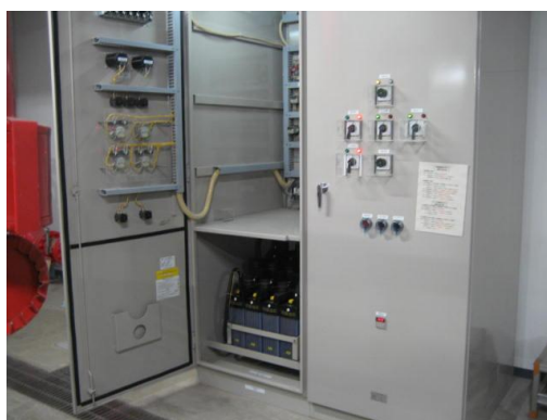
D/G消火ポンプ(エンジン)、バッテリー
