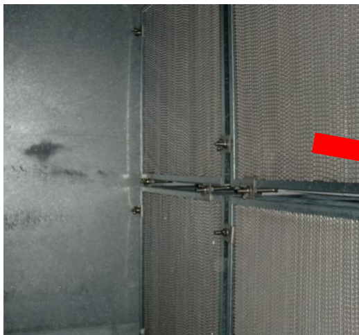
フィルタユニット内部 (フィルタ取り付けイメージ)
