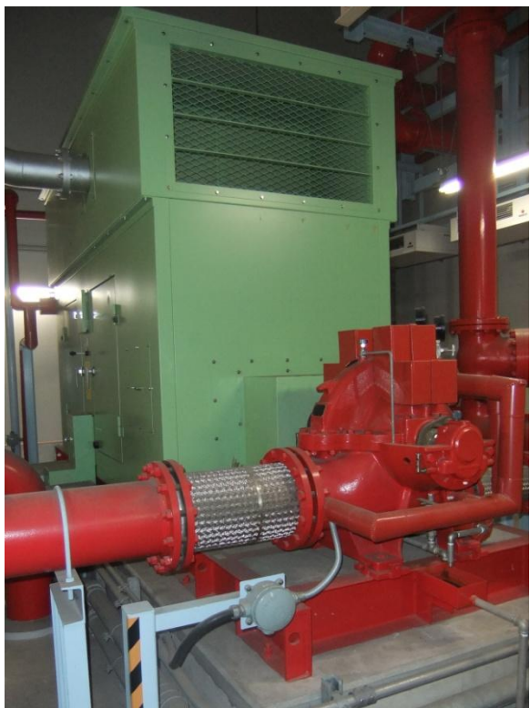
D/G消火ポンプ(エンジン)、バッテリー
