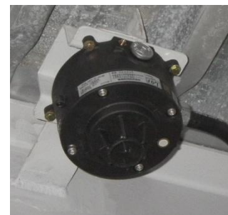
定温式スポット型熱感知器(防爆型)
