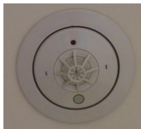
差動式スポット型熱感知器
