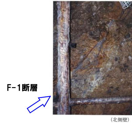
F-1断層露頭写真(C坑) 始点からの距離約20m
