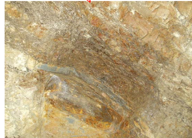
F-11断層露頭写真(C坑南東壁 TD30.0)
