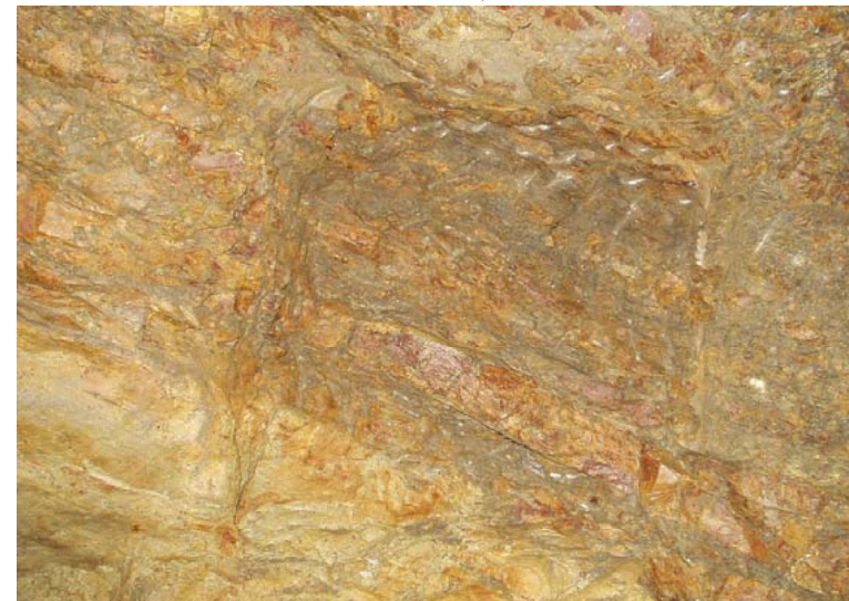
F-11断層露頭写真(B坑南東壁 TD88.0)
