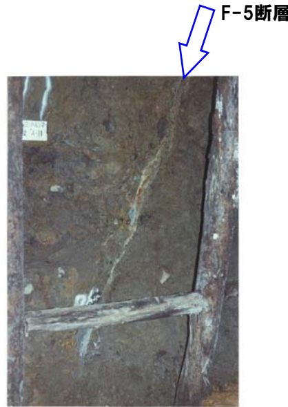
F-5断層露頭写真(A-2坑) 始点からの距離34m
