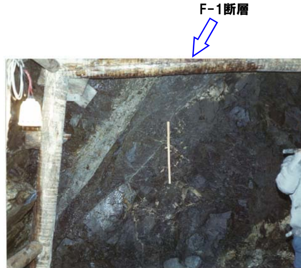
F-1断層露頭写真(A-1坑) 始点からの距離254.9m(切羽)
