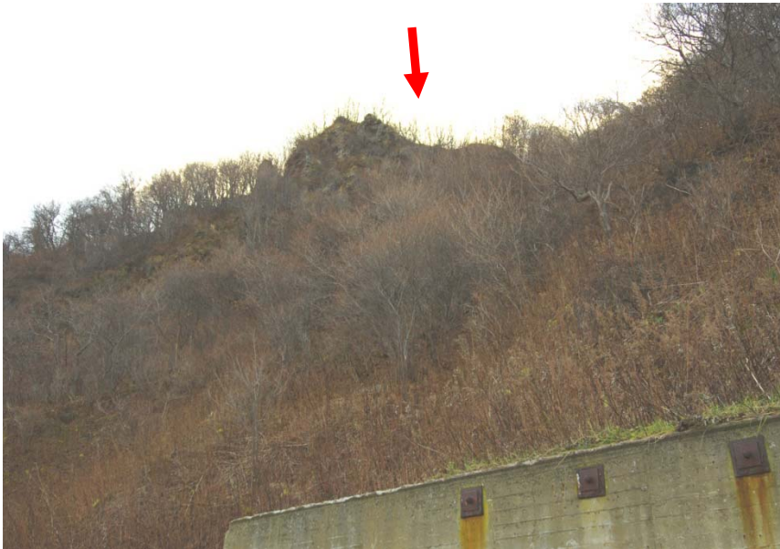
写真1:ブロック2及びブロック4の境界付近には、堅硬な火山礫凝灰岩が分布し、ブロックの地すべりを示唆する段差や破碎は認められない。
