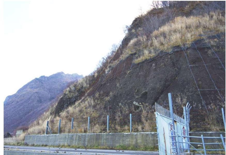
写真2:ブロック2の中央・先端部のカスペノ岬付近には、堅硬な火山礫凝灰岩が分布し、ブロックの地すべりを示唆する段差や破碎は認められない。
