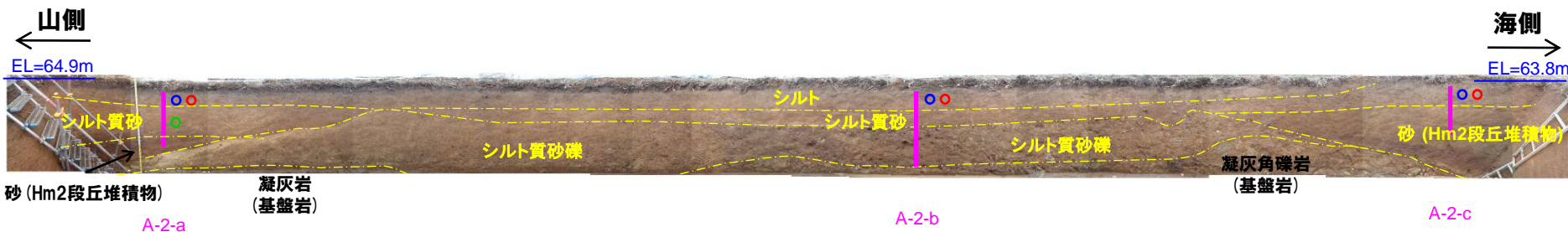
トレンチ壁面写真 (A-2)
