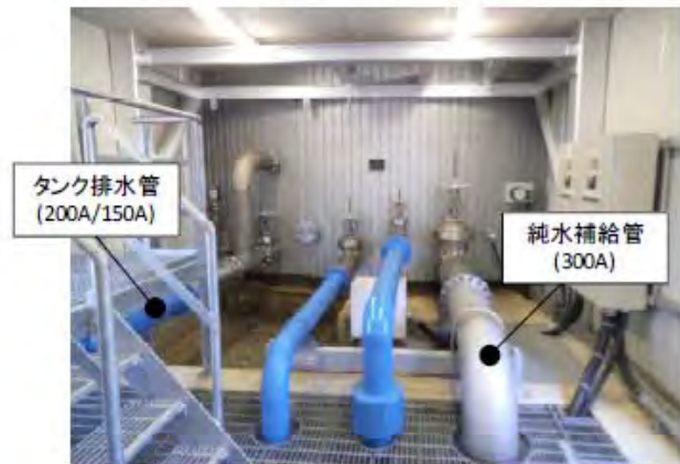
3号機ろ過水タンク接続配管(Aタンク側)
