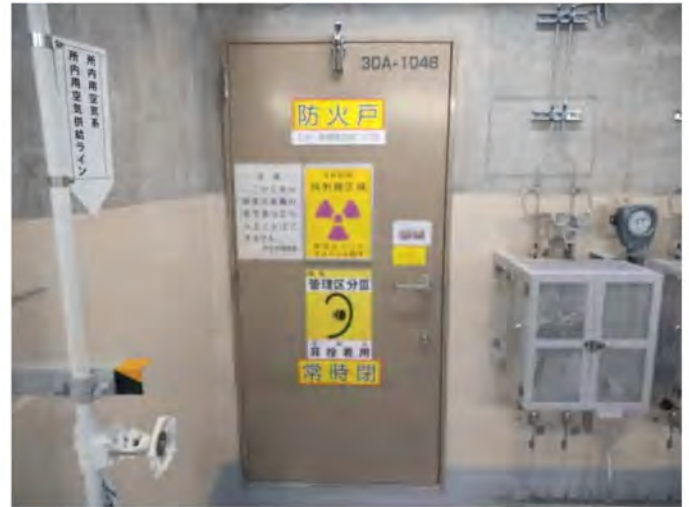
(8) A-余熱除去ポンプ室扉
