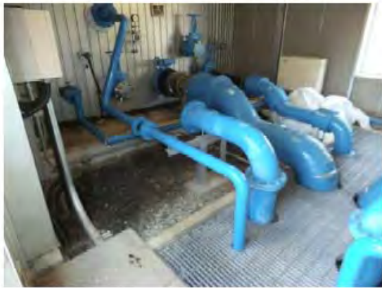
1,2号機ろ過水タンク接続配管(Aタンク側)
