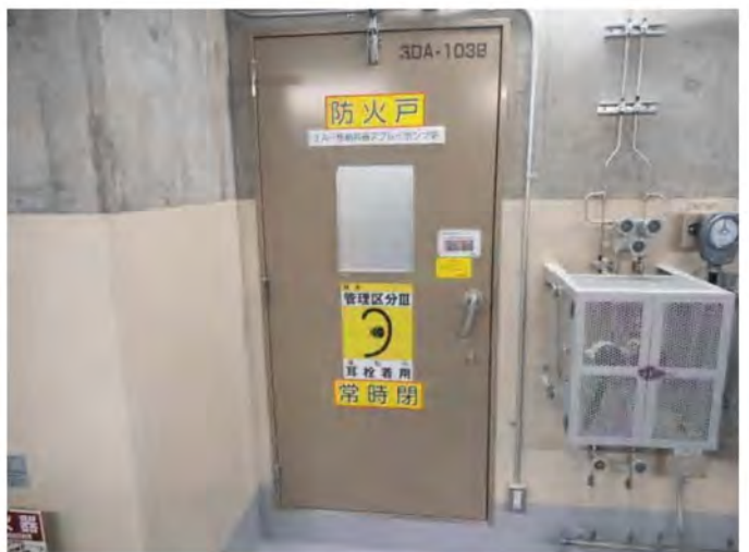
(6) A-格納容器スプレィポンプ室扉
