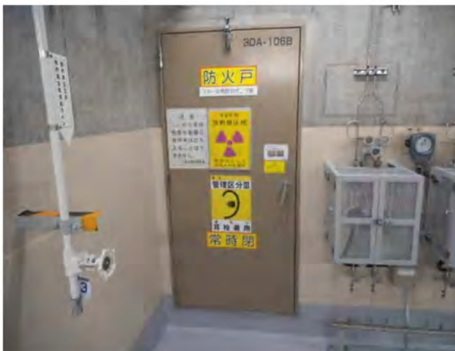
(9) B-余熱除去ポンプ室扉
