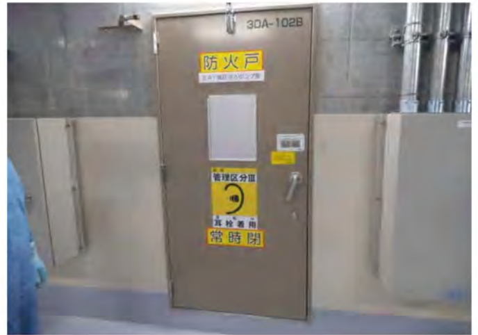
(4) A-高圧注入ポンプ室扉
