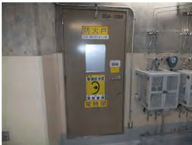
(5) B-高圧注入ポンプ室扉
