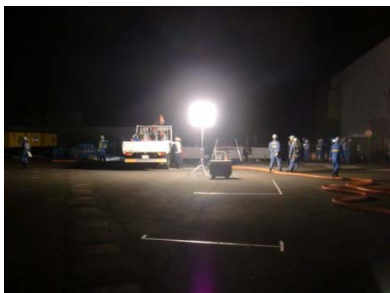
代替給水ホース敷設
