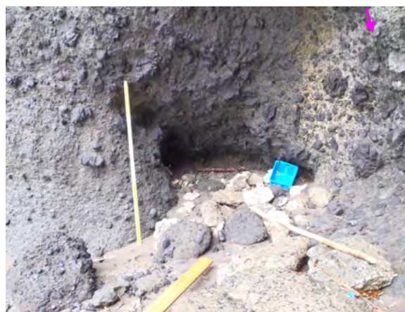
全景(祈石南⑦)
