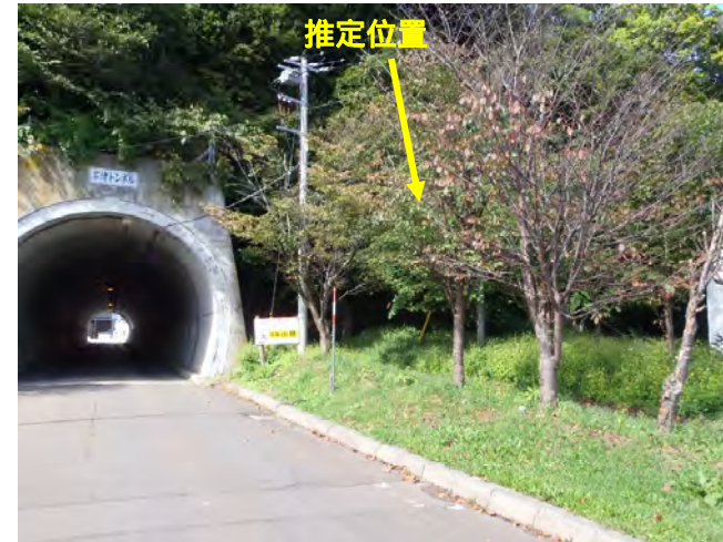
全景 (トンネル北側)
