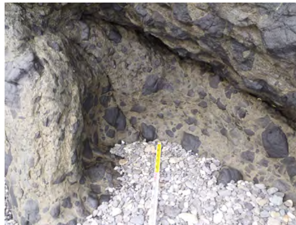
底面の状況(祈石南14)
