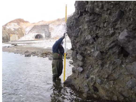
岩盤部のノッチ(日司①北側)
