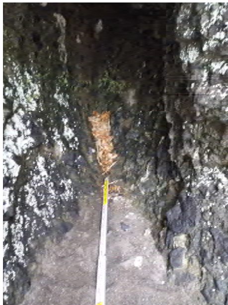
底面の状況(祈石南15)
