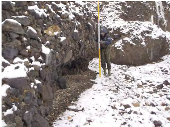
岩盤部のノッチ(兜⑦北側)
