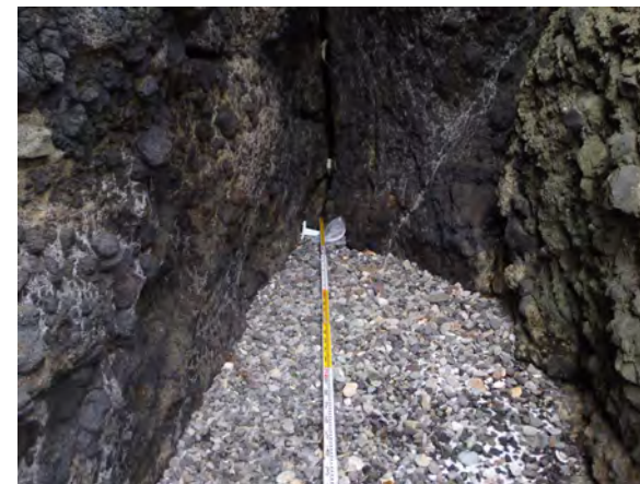
底面の状況(稲荷神社下①)
