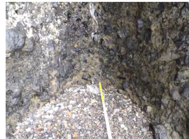
底面の状況(祈石南13)
