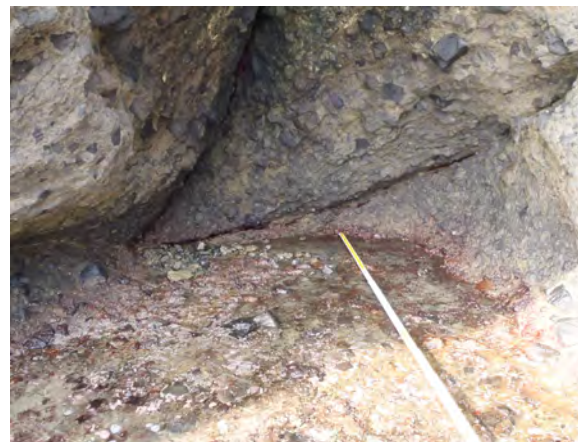
底面の状況(祈石南⑪)
