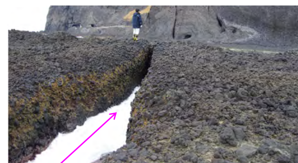
写真④ (波食溝状況)
