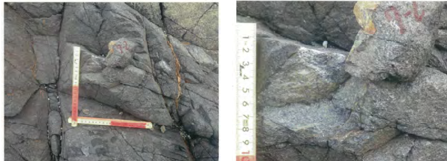
岩相状況写真
