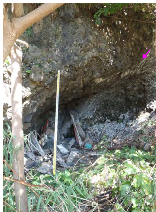
開口部の状況
