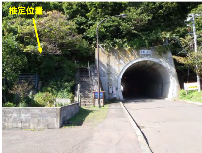
全景 (トンネル南側)
