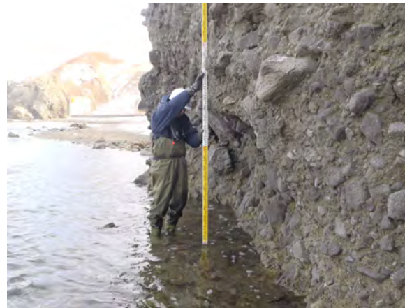
岩盤部のノッチ(日司①北側)
