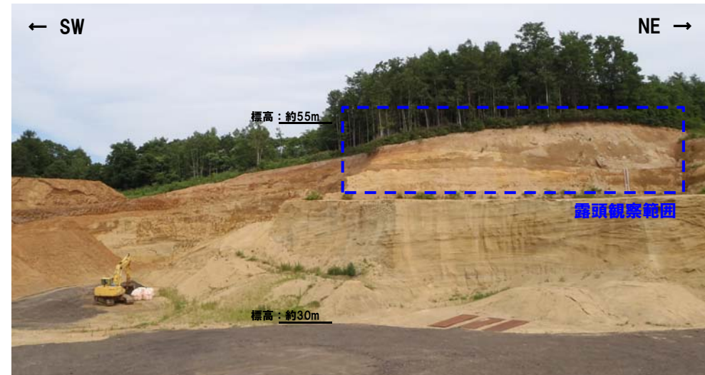
幌似露頭1全景
