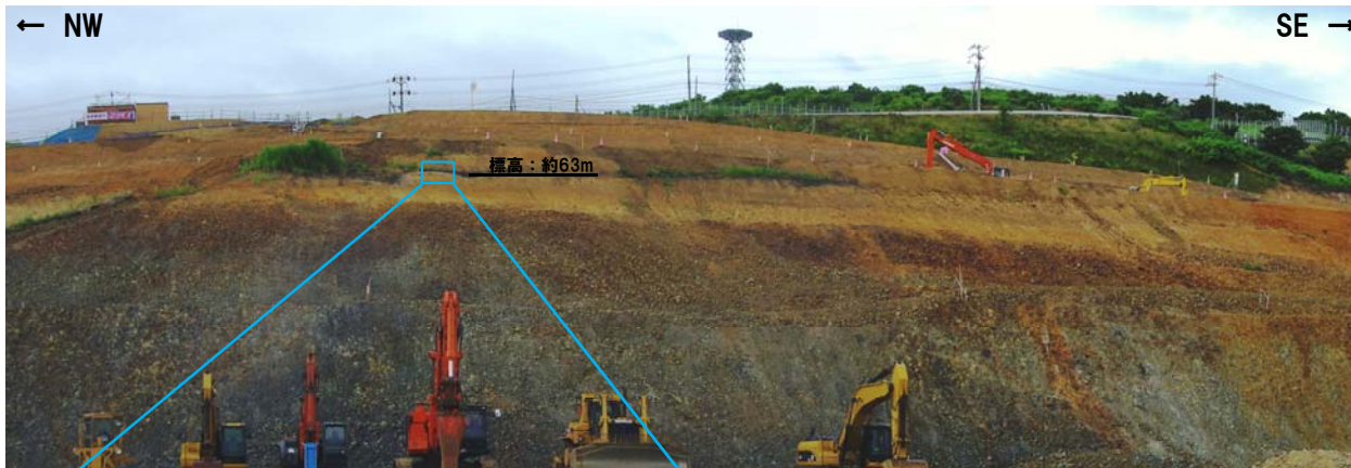
写真 (平成25年度造成工事实施時)
