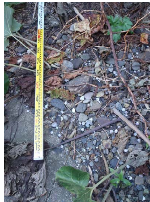
洞穴底面の状況
