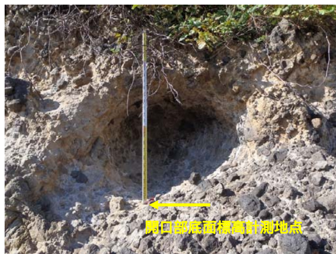
開口部の状況
