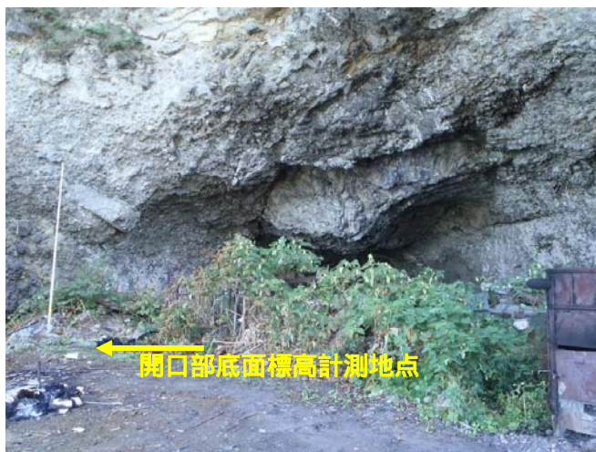
開口部の状況
