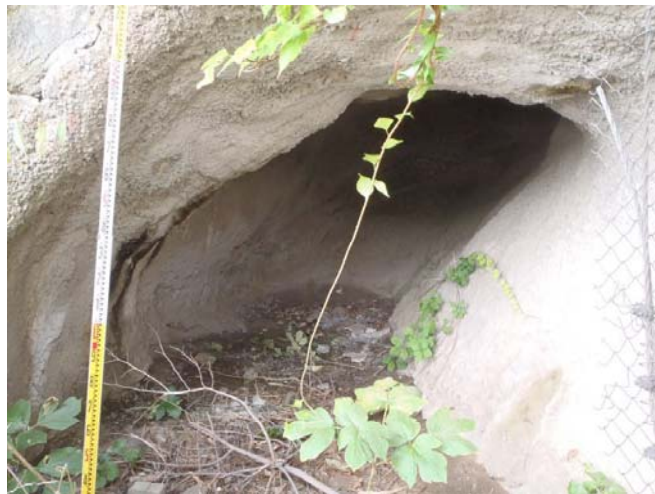
開口部の状況
