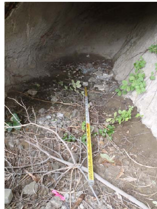
洞穴底面の状況
