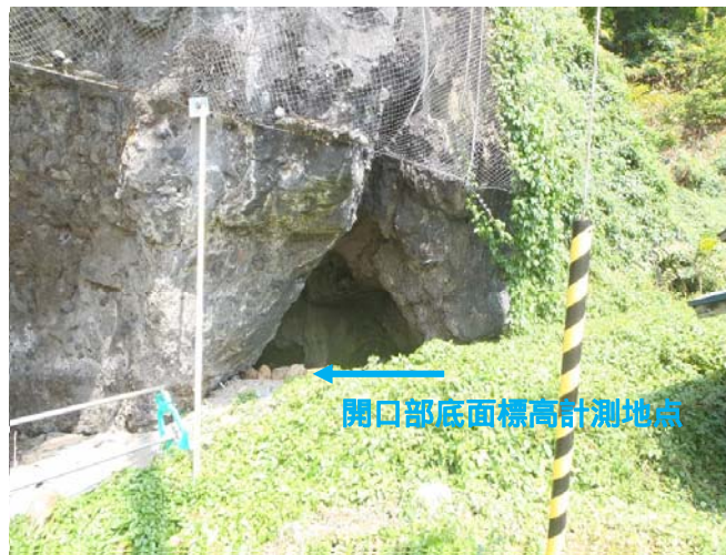
開口部の状況
