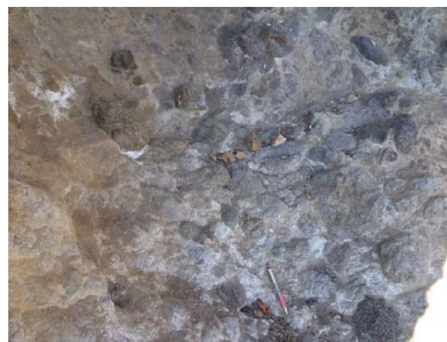
洞穴底面の状況
