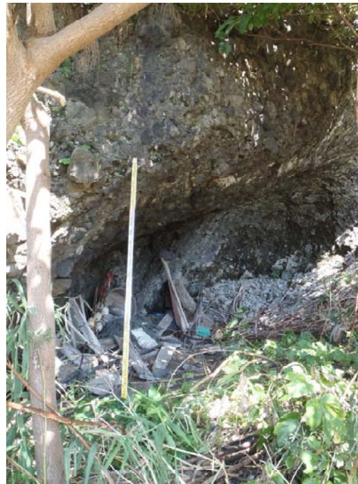
開口部の状況
