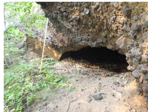
開口部の状況
