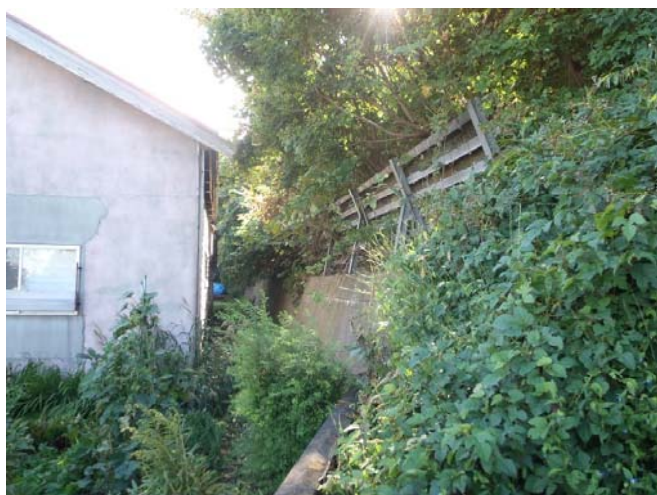
トンネル南側洞穴推定位置
