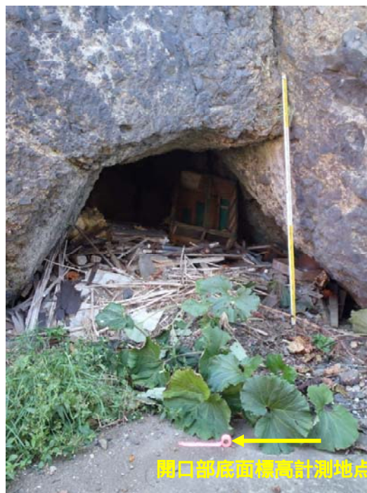
開口部の状況
