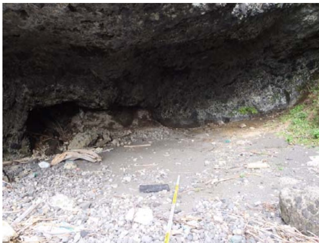
開口部の状況
