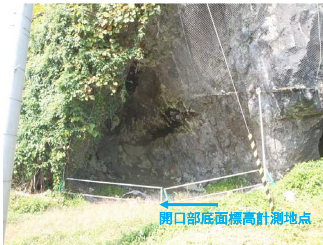
開口部の状況
