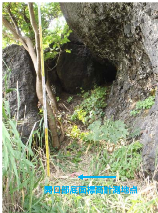
近景 (南側より撮影)
