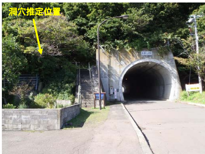
全景(トンネル南側)
