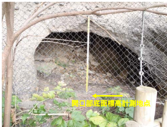
開口部の状況
