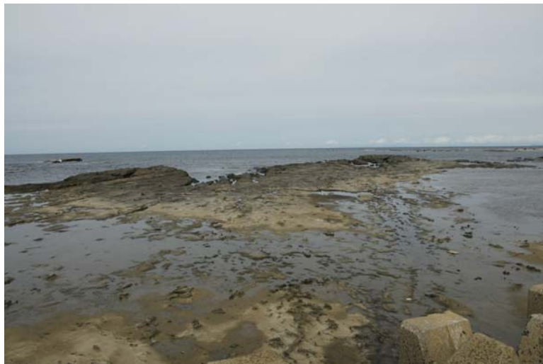
写真c. 大戸瀬駅付近離水波食棚状況 (砂岩)
