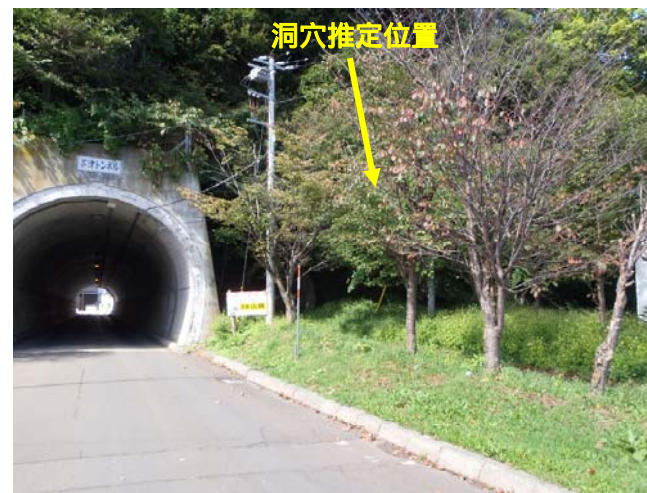
全景(トンネル北側)
