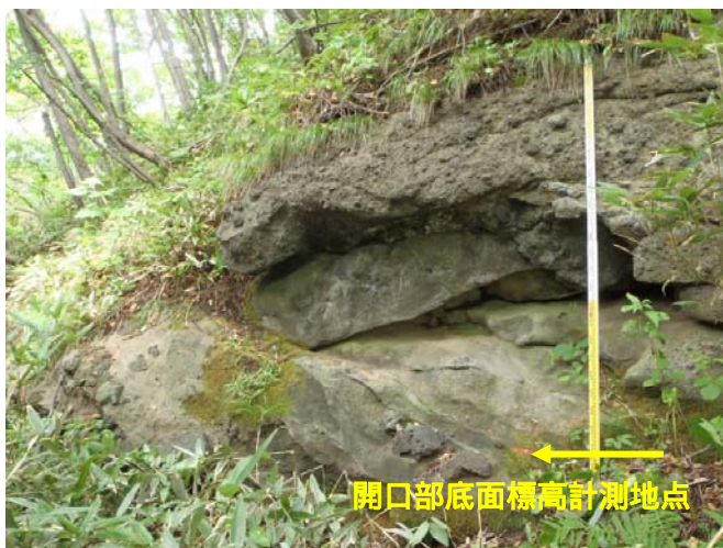
開口部の状況
