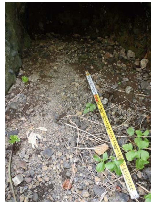
洞穴底面の状況
