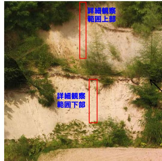
本露頭は、土取り場であったことから、斜面の安定を図るための小段が設けられている。
