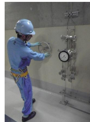
流量調節弁と 流量計の配置(例)
