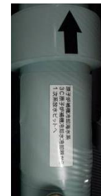
原子炉補機 冷却海水系統
