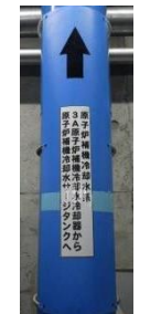
原子炉補機 冷却水系統
