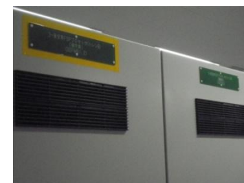
不要負荷切り離し対象盤の識別 (反射テープ) (例)
