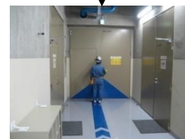
③原子炉補助建屋から 原子炉建屋への境界扉
