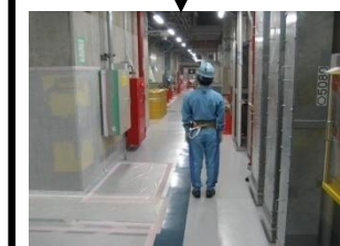
⑥A-D階段からA-A階段入口扉まで移動
