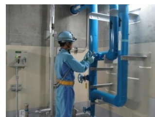
⑧ 高圧注入ポンプ室系統構成 操作イメージ
