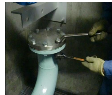
閉止フランジの取り外し(写真: SWS側閉止フランジの取り外し)
