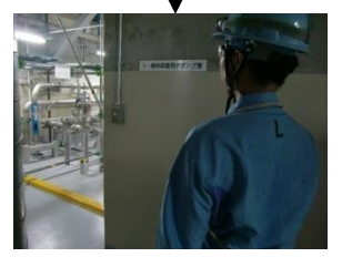
⑤ R-B階段から燃料取替用水ポンプエリアへ
