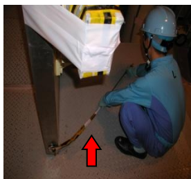
【内側扉閉止準備】
