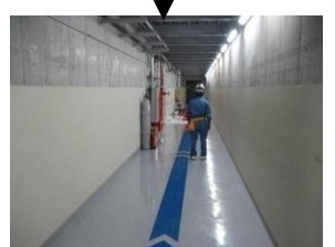
③原子炉補助建屋内、A-D階段入口扉へ移動
