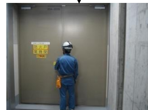
②原子炉建屋から原子炉補助 建屋への境界扉
