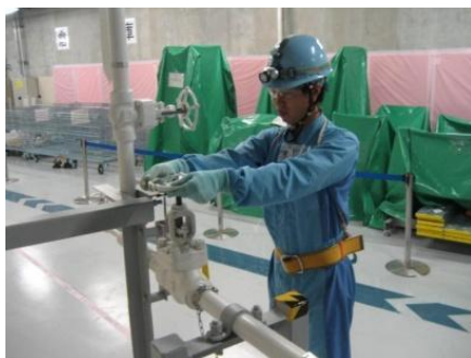
②格納容器貫通部エリア(T.P.17.8m) 格納容器隔離弁操作イメージ
