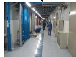
④原子炉補助建屋から R-D階段へ移動
