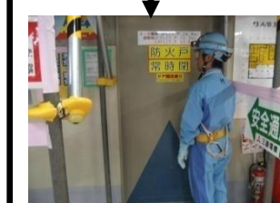
⑦A-A階段入口扉
