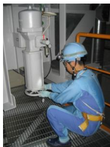
①T.P33.1m アニュラス空気浄化ファン室 アニュラス排気ダンパ手動ハンドル操作
