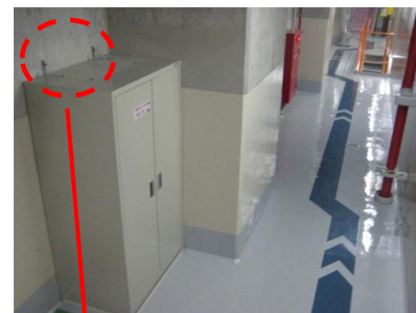
ボルトにより壁に固定
