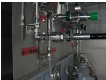
③窒素ガスボンベのカップラ接続後
