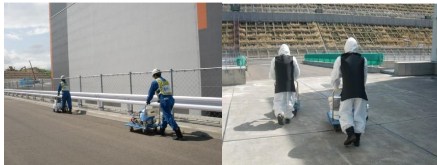
Step No. 10-a-2 ホース保管場所から敷設場所へのホース移動
