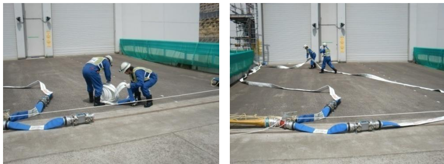
屋外ホース敷設距離:20m程度
