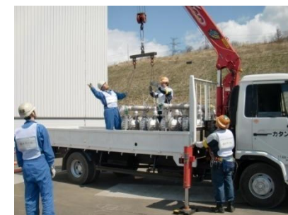
空気作動式ポンプ吊り下 ろし作業
