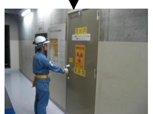
④A-D階段入口扉
