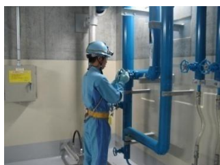
④ 格納容器スプレイポンプ室 系統構成操作イメージ
