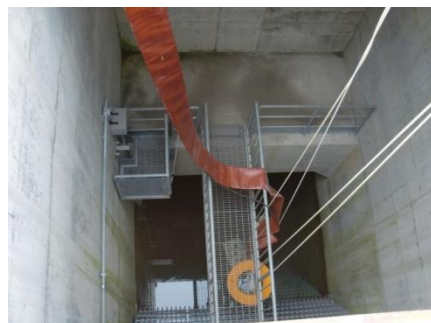
スクリーン室へ設置(海水につける直前で吊っている状態) した水中ポンプ
