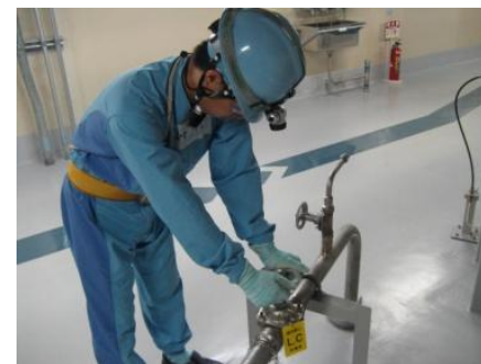
⑥格納容器貫通部エリア(T.P.21.2m) 格納容器隔離弁操作イメージ
