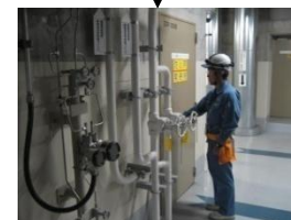
⑤R-D階段入口扉
