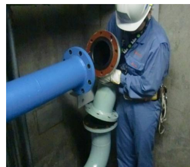
スプールピースの取り付け
