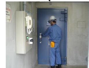
⑥屋外を経由し、循環水ポンプ 建屋へ
