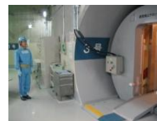
④R-B階段から格納容器 通常エアロック室へ
