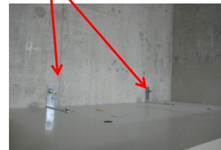
ボルトにより壁に固定
