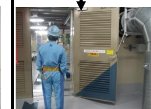
⑨原子炉補助建屋から原子炉建屋への境界扉
