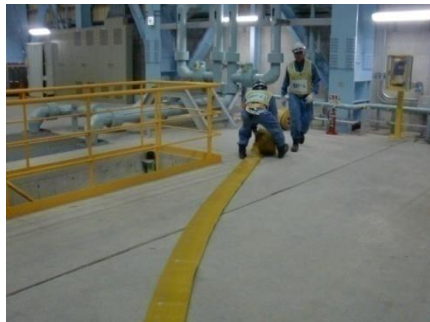
循環水ポンプ建屋内でのホース敷設作業。 (ホース敷設距離: 30m程度)
