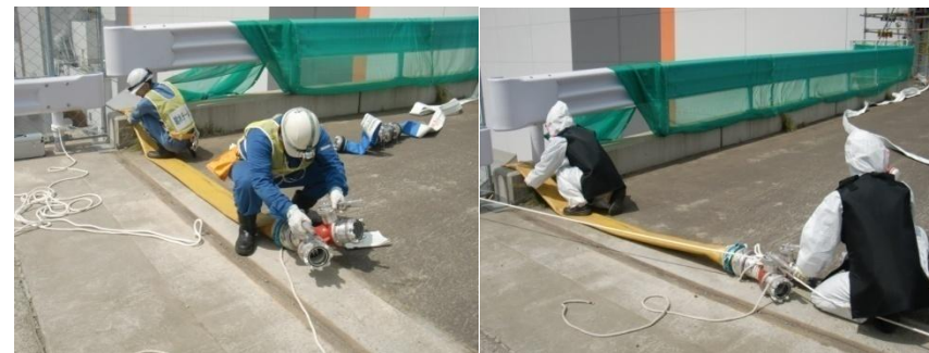
Step No. 10-b-3 法面部へのホース敷設
