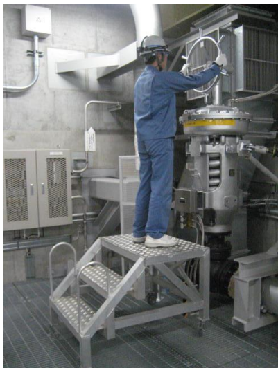
①A-主蒸気逃がし弁開放操作 (足場使用)
