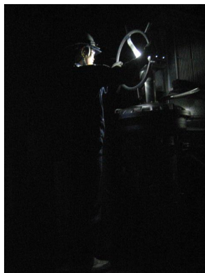
②主蒸気逃がし弁開放操作 (照明消灯時)
