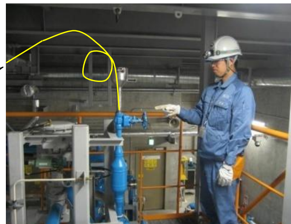
②原子炉補機冷却水サージタンク薬品添加口止め弁操作
