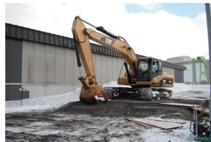
スロープ整形状況
