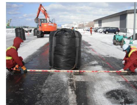
大型土嚢配置状況
