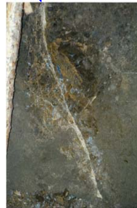
F-6断層露頭写真 (No.9坑) 切羽
