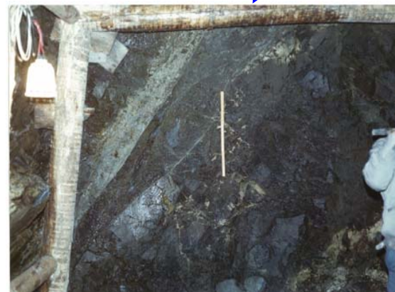
F-1断層露頭写真 (A-1坑) 始点からの距離254.9m (切羽)
