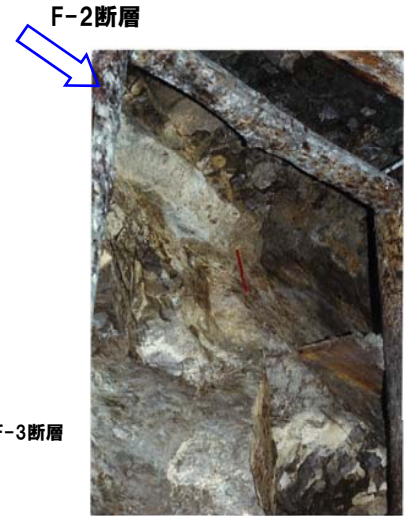
F-2断層露頭写真 (G坑) 始点からの距離115m
