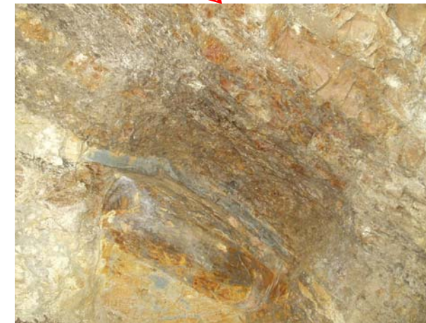
F-11断層露頭写真 (C坑) 始点からの距離30m
