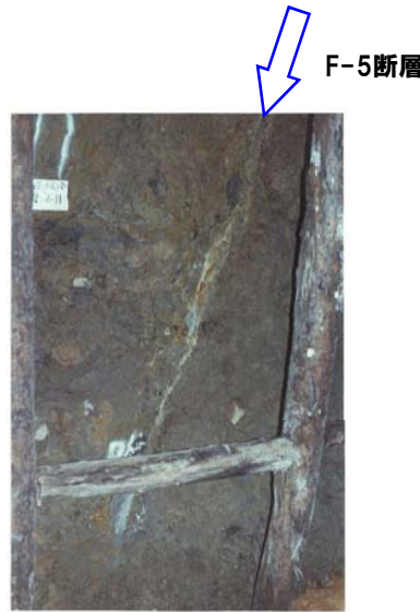
F-5断層露頭写真 (A-2坑) 始点からの距離34m
