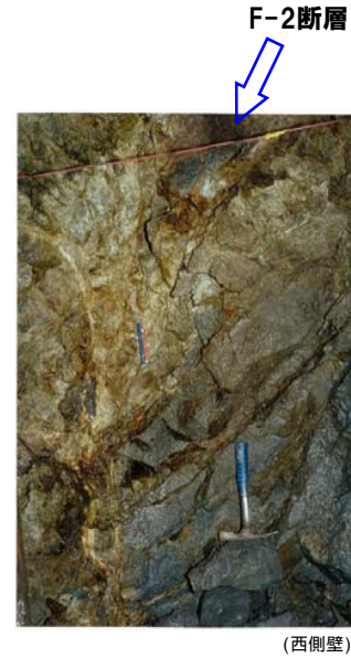
F-2断層露頭写真 (A-2坑) 始点からの距離約204m
