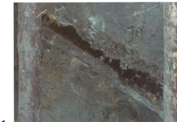
F-3断層露頭写真 (G坑始点からの距離120m)
