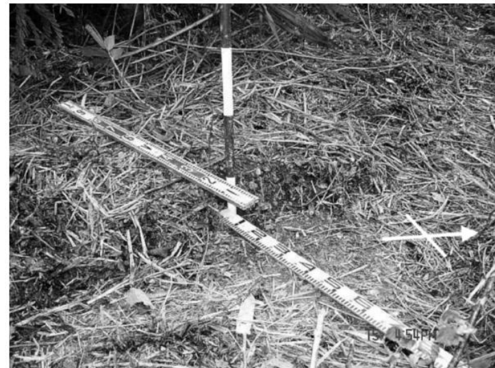
写真-1 尾根部で確認された13cmの段差 写真位置は図-4参照.
