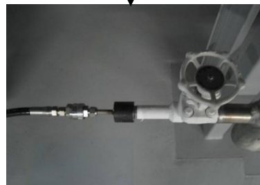
⑦加圧器逃がし弁側ホース接続後
