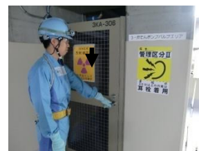
④ 充てんポンプ室前から 充てんポンプ上部バルブエリアへ
