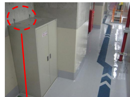
ボルトにより壁に固定
