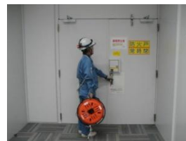
①中央制御室
