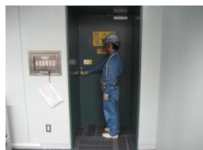
① 中央制御室
