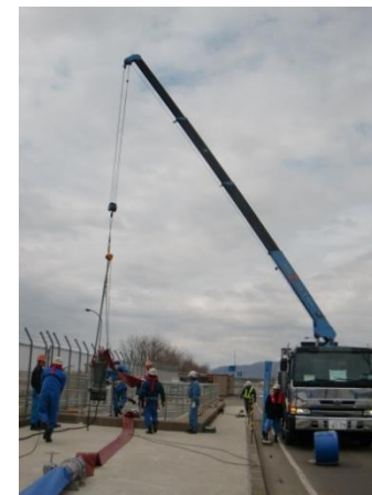
水中ポンプ吊り下ろし作業
