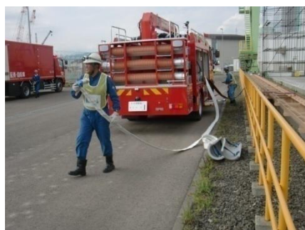
可搬型大型送水ポンプ車出口 へ接続したホース
