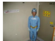
②格納容器貫通部エリア (T.P.21.2m)からR-B 階段へ
