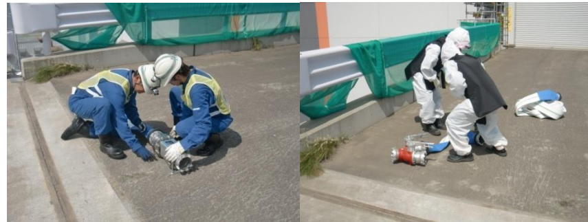
Step No. 10-a-3 ホース敷設(屋外)
