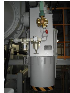
⑦アニュラス空気浄化ファンダンパ (原子炉建屋 T. P40. 3m)
