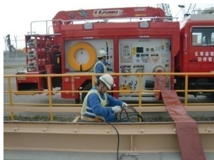
水中ポンプと可搬型大型 送水ポンプ車入口とのホース 接続作業
