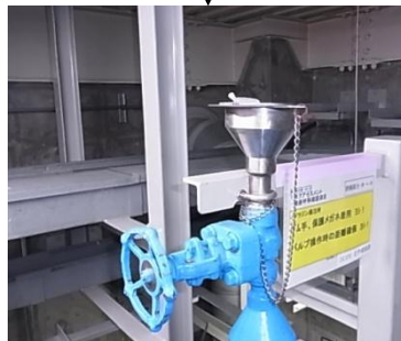
④原子炉補機冷却水サージタンク 薬品添加口への高圧ホースの取付け
