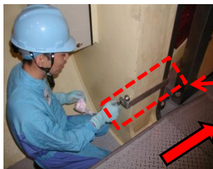
【エアロック側保護カバー取外し】
