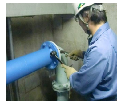
スプールピースの締め付け
