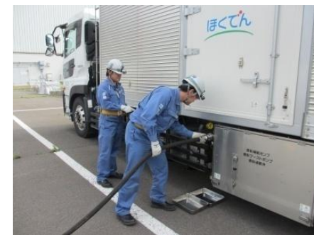
④代替非常用発電機燃料タンク へ給油ホースの接続
