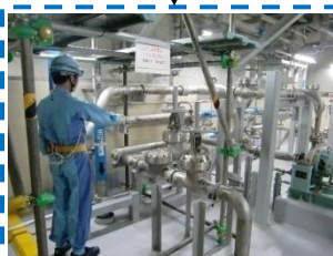
⑥ 燃料取替水ポンプエリアへ(設置予定箇所)
