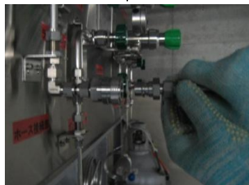
②窒素ガスボンベのカップラ接続前
