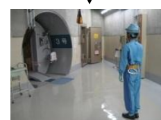
⑧R-B階段から格納 容器非常用エアロック 室へ
