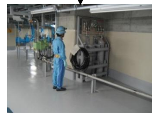
⑧加圧器逃がし弁操作用可搬式窒素ガスポンペエリア
