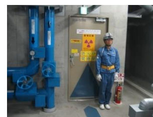
③A-D階段から補助建屋給気空調機械室へ
