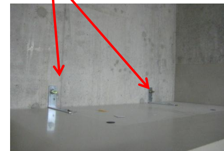
ボルトにより壁に固定
