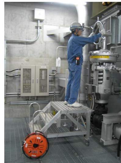
①A-主蒸気逃がし弁開度調整 (足場使用)
