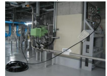
⑧窒素ガスボンベのホース接続
