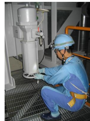
⑧アニュラス空気浄化ファンダンパ (原子炉建屋 T. P. +33. 1m)
