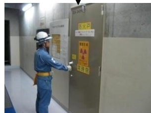
④A-D階段入口扉
