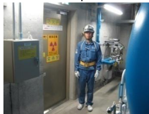
④ 補助建屋給気空調機械室からR-B階段入口扉へ
