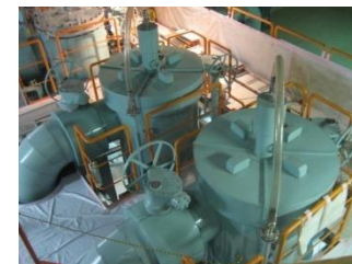
⑨ 原子炉補機冷却海水ポンプ 出口ストレーナエリア
