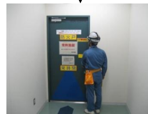
③A-F階段入口扉へ
