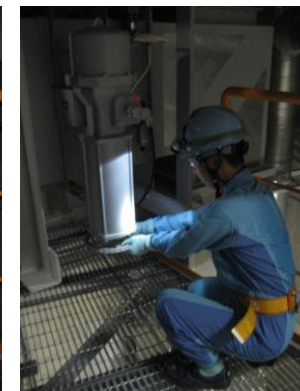
⑧アニュラス空気浄化ファンダンパ (原子炉建屋 T. P. +33. 1m)
