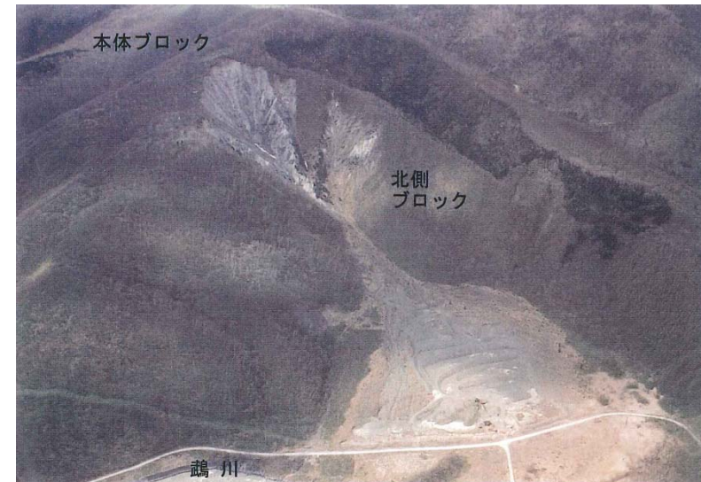
写真2:むかわ町八幡地区の地すべり 滑落崖の平面形が馬蹄形を示す。 北海道地すべり学会 (2012) より
