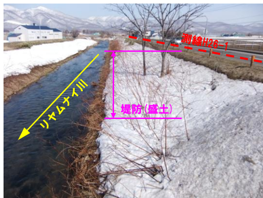
リヤムナイ川堤防(盛土)状況
