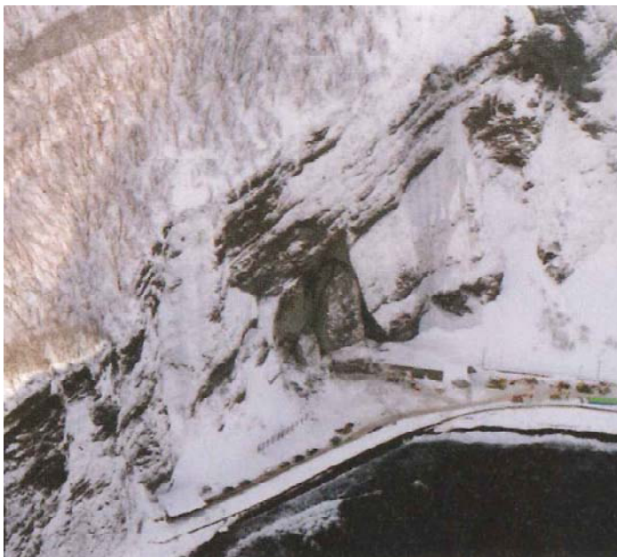
豊浜トンネル崩壊箇所全景 北海道地すべり学会（2012）より
