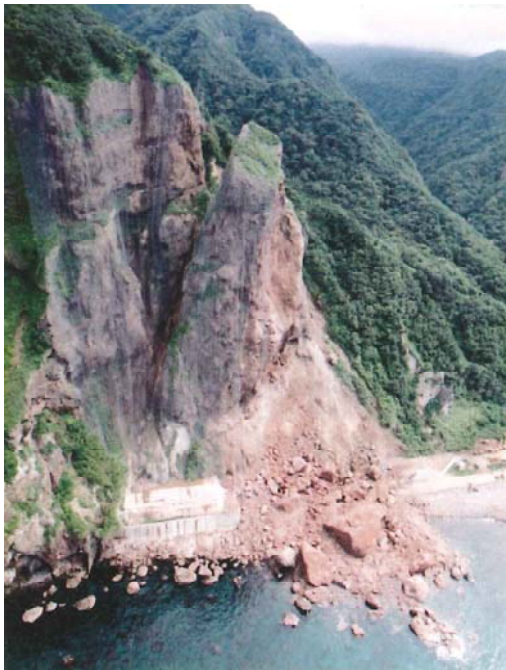
第2白糸トンネル第1回崩壊箇所全景 北海道地すべり学会(2012)より
