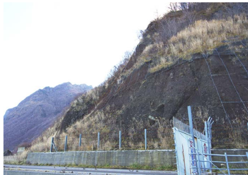
写真2:ブロック2の中央・先端部のカスペノ岬付近には、堅硬な火山礫凝灰岩が分布し、ブロックの地すべりを示唆する段差や破碎は認められない。
