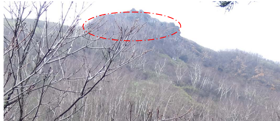
写真5:大天狗山前縁の露岩状況(遠望) 頂部には露岩が認められるが、斜面はほとんど植生に覆われている。
