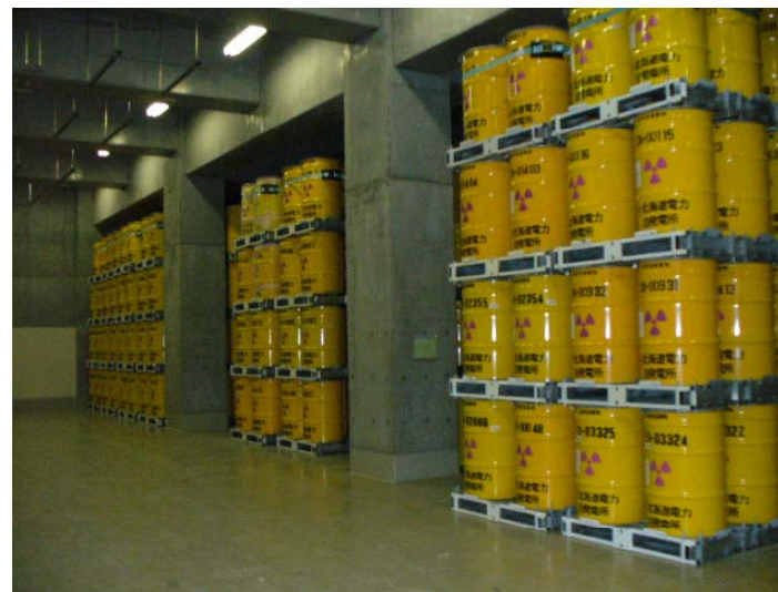
固体廃棄物貯蔵庫(内部)
