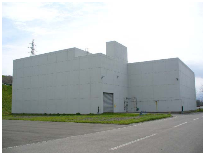
固体廃棄物貯蔵庫(外観)
