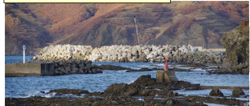
日司周辺状況写真(HT3付近, Vb)
