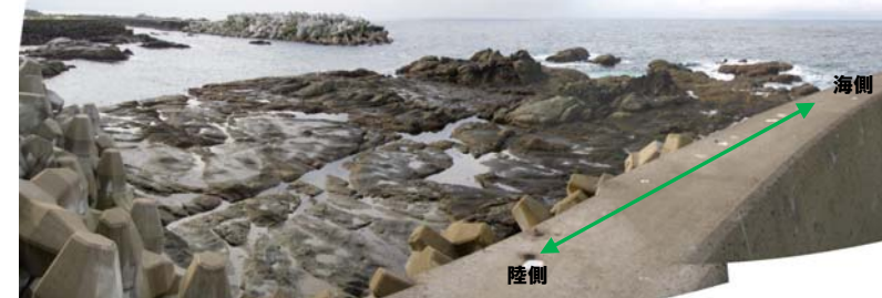
川白周辺状況写真(KS4付近, Hyalo)
