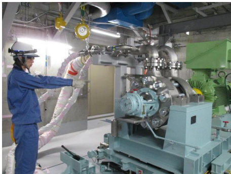
①代替格納容器スプレイポンプ 起動確認イメージ
