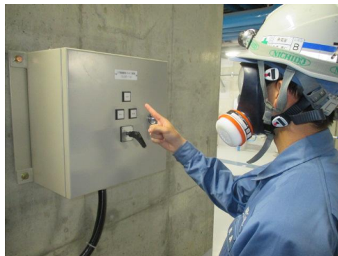
①代替格納容器スプレイポンプ起動操作 (防護具着用)
