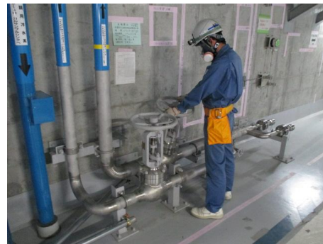
②代替格納容器スプレイポンプ 系統構成操作イメージ
