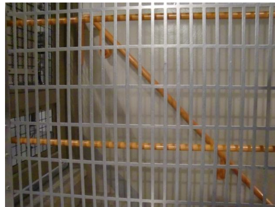
図4 階段開口部に設置したパンチングメタル
