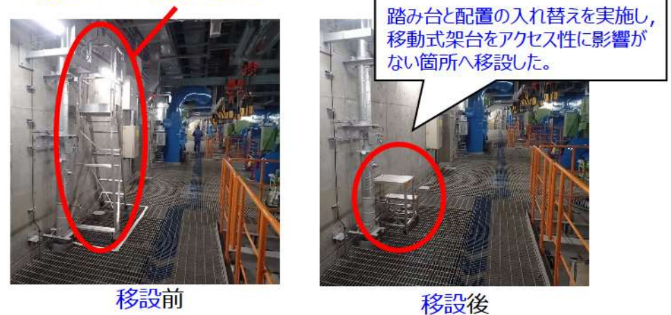
図9-2 資機材移設処置の状況
