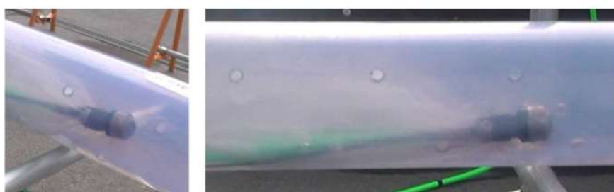
添付 5-4(4) 図 管内清掃装置進行時の様子
