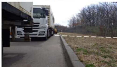
P6 開閉所周回道路の状況 防災科研調査において示される側方崖と地滑り土塊の境界に当たる。 当該箇所付近に地滑りを示唆する変状(緑石及びフェンスのずれ)は認められない。
