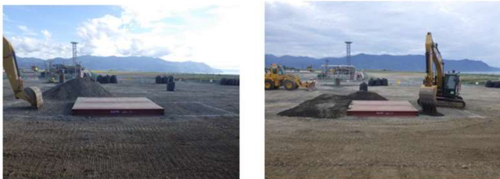
第10図 段差復旧状況
