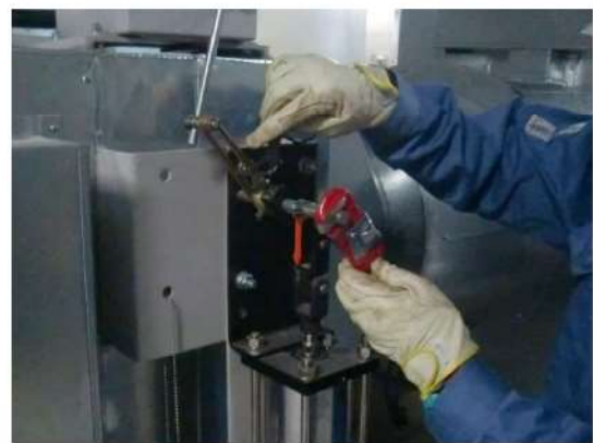
(空気作動ダンパ閉作業イメージ)
