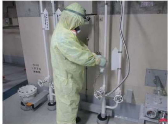
(制御用空気供給弁閉操作イメージ)
