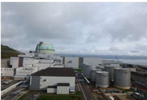
2号炉タービン建屋屋上
