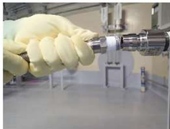
アニュラス排気ダンパのカプラ接続 イメージ (周辺補機棟 T.P. 40.3m)
