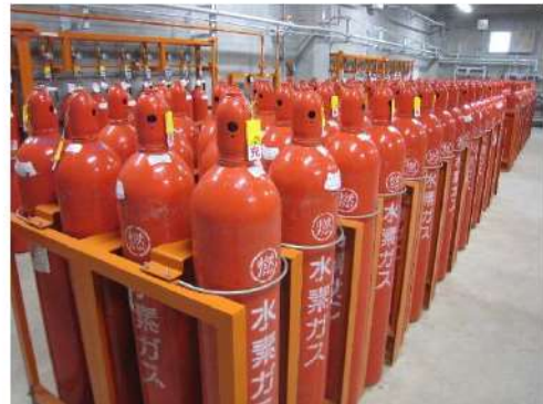
2号炉発電機ガスボンベ庫
