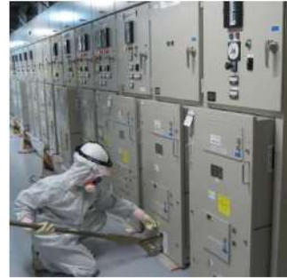
受電遮断器操作 (安全補機開閉器室) (原子炉補助建屋T. P. 10. 3m)
