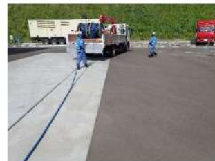
号炉間連絡予備ケーブル敷設（屋外）
