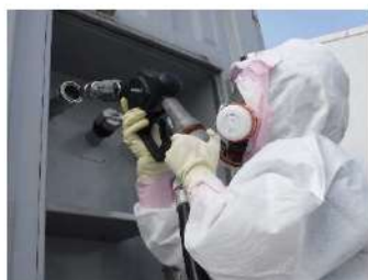
代替非常用発電機の給油口へのホース接続（クイックカップラ式） （代替非常用発電機） （屋外）
