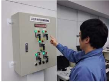
後備変圧器遮断器操作 (中央制御室) (原子炉補助建屋T. P. 17. 8m) (作業風景は類似作業)
