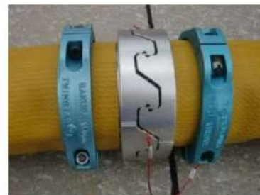
可搬型ホース（150A）接続後
