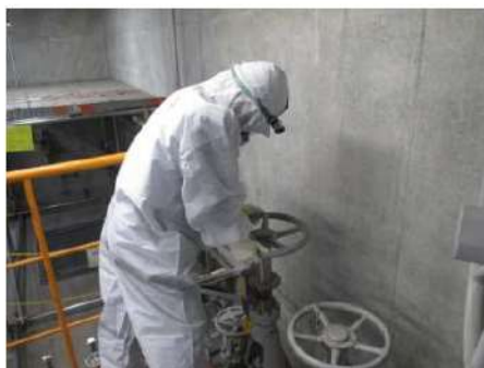
補助給水ピット水源切替 系統構成 (周辺補機棟 T. P. 24.8m)
