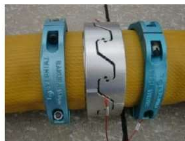
可搬型ホース（150A）接続後
