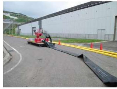
放水砲設置 (屋外)
