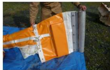
荷揚場シルトフェンス端部
