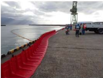
荷揚場シルトフェンス設置状況 (赤の遮水壁：ボックスウォール) (屋外)
