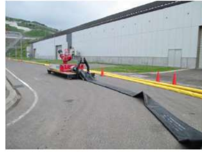
放水砲設置 (屋外)
