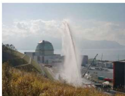
第2図 直線状放射による放水状況
