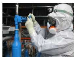
原子炉補機冷却水系加圧操作 (周辺補機棟 T. P. 43. 6m)
