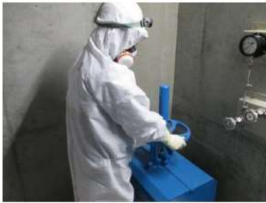
補機冷却水（海水） 通水開始前系統構成 （周辺補機棟 T. P. 17. 8m）
