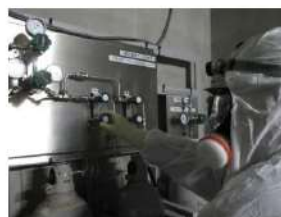
原子炉補機冷却水系加圧 系統構成 (周辺補機棟 T. P. 43. 6m)
