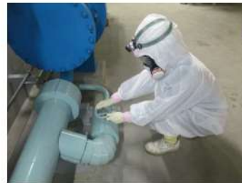
原子炉補機冷却海水系水抜き (ディーゼル発電機建屋 T.P. 6.2m)
