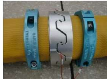
可搬型ホース (150A) 接続後
