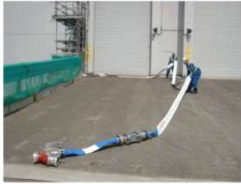
可搬型ホース敷設 (屋外) (作業風景は類似作業)
