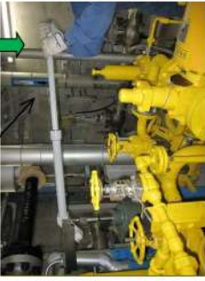
起動レバー (約 10 kg) 押し下げる
