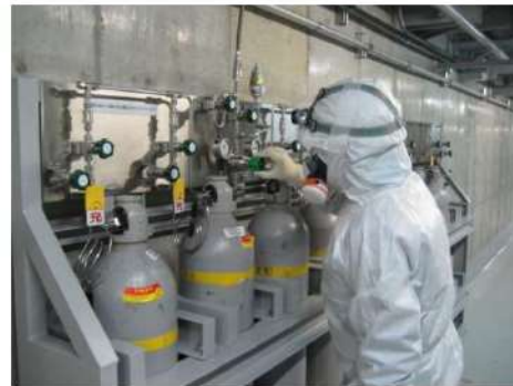
主蒸気逃がし弁 代替制御用空気供給操作 (周辺補機棟 T. P. 10. 3m)
