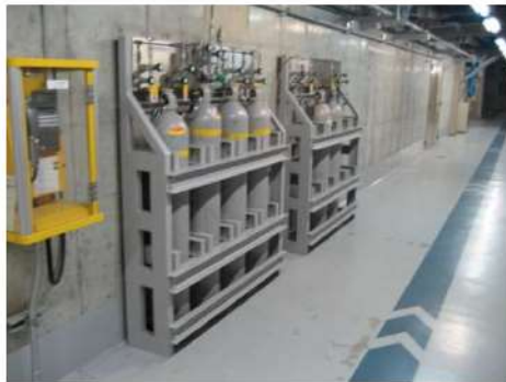
主蒸気逃がし弁操作用 可搬型空気ポンベ (周辺補機棟 T. P. 10. 3m)
