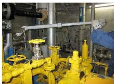
専用工具（蒸気加減弁開操作用）操作 （周辺補機棟 T. P. 10. 3m）
