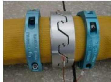
可搬型ホース(150A)接続後
