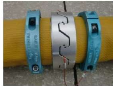
可搬型ホース(150A)接続後
