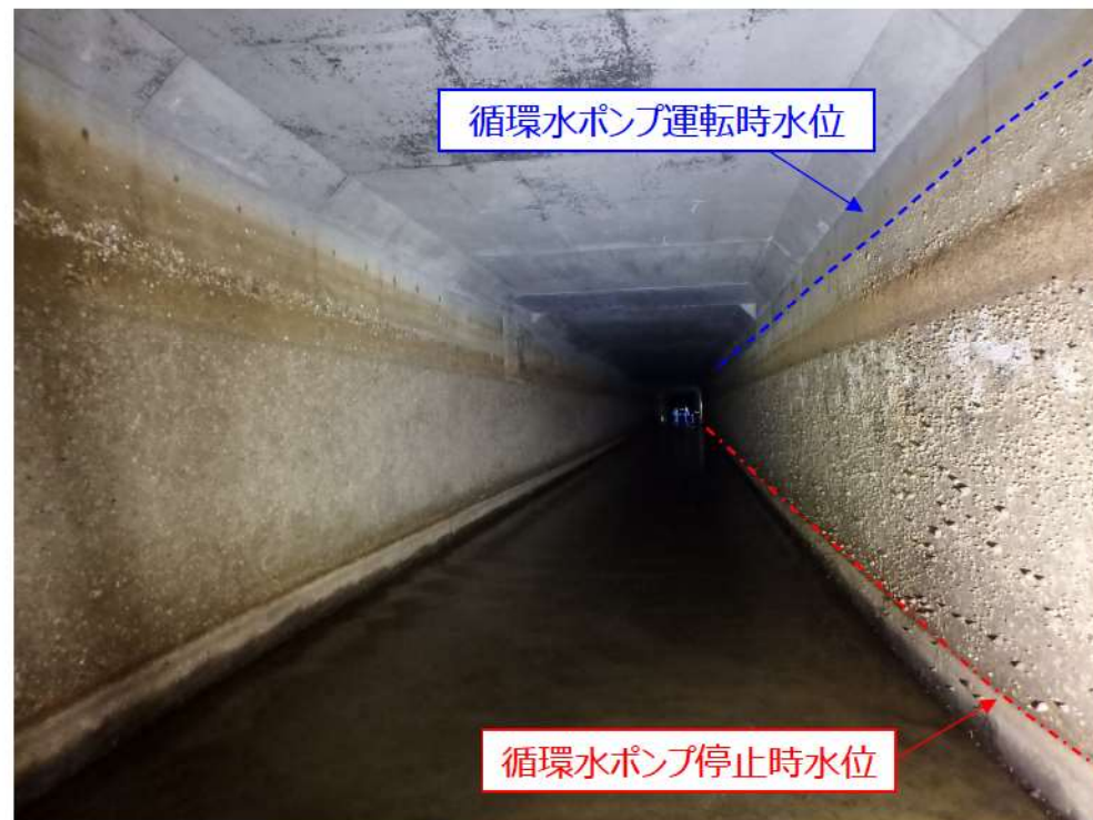
図1 1号炉放水路状況（2023年2月）
