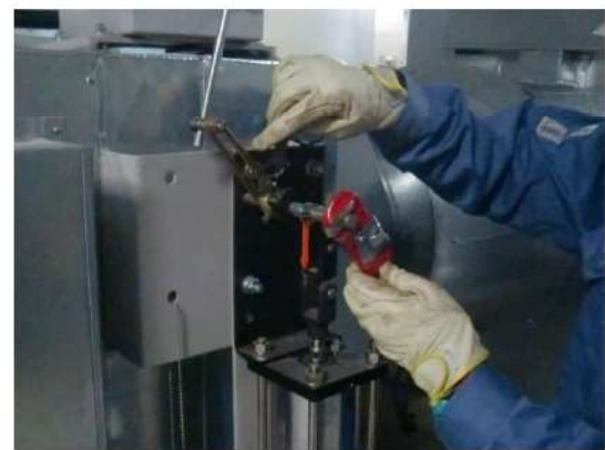
(空気作動ダンパ閉作業イメージ)
