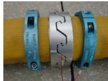
可搬型ホース（150A）接続後
